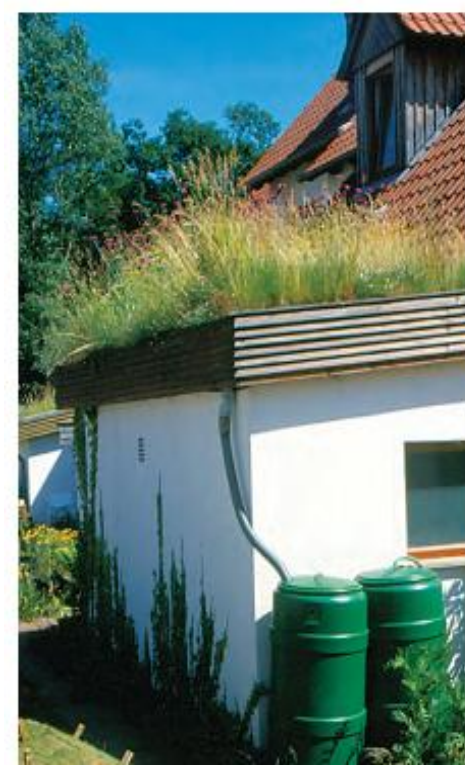
Vorbildlich: Das Dach des Anbaus ist begrünt und überschüssiges Wasser wird in Regentonnen aufgefangen
