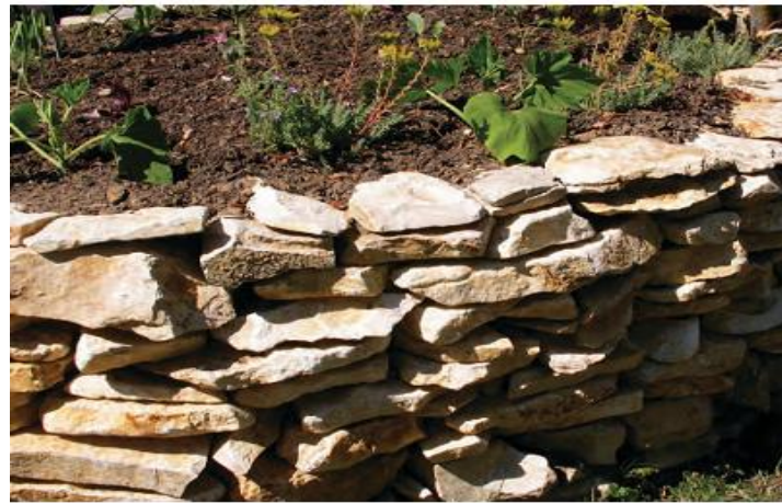
Hochbeet - Einfassung mit Trockenmauer
